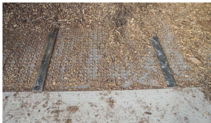
Ebene Einfahrt durch integrierten Belüftungsboden
