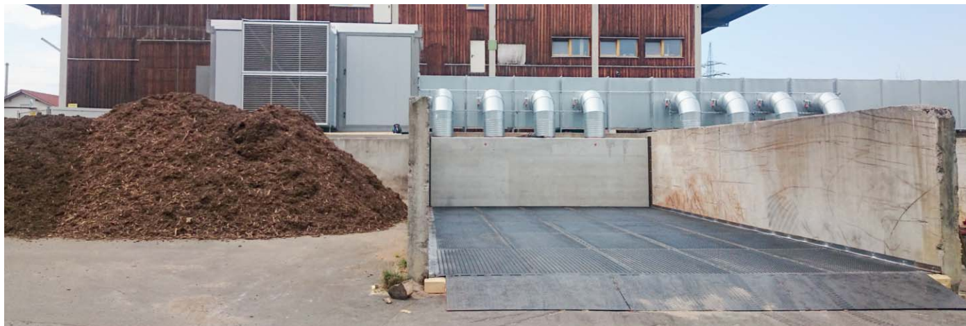
Structure de la construction de base ou des parois des boxes de séchage possible en bois, béton ou acier
